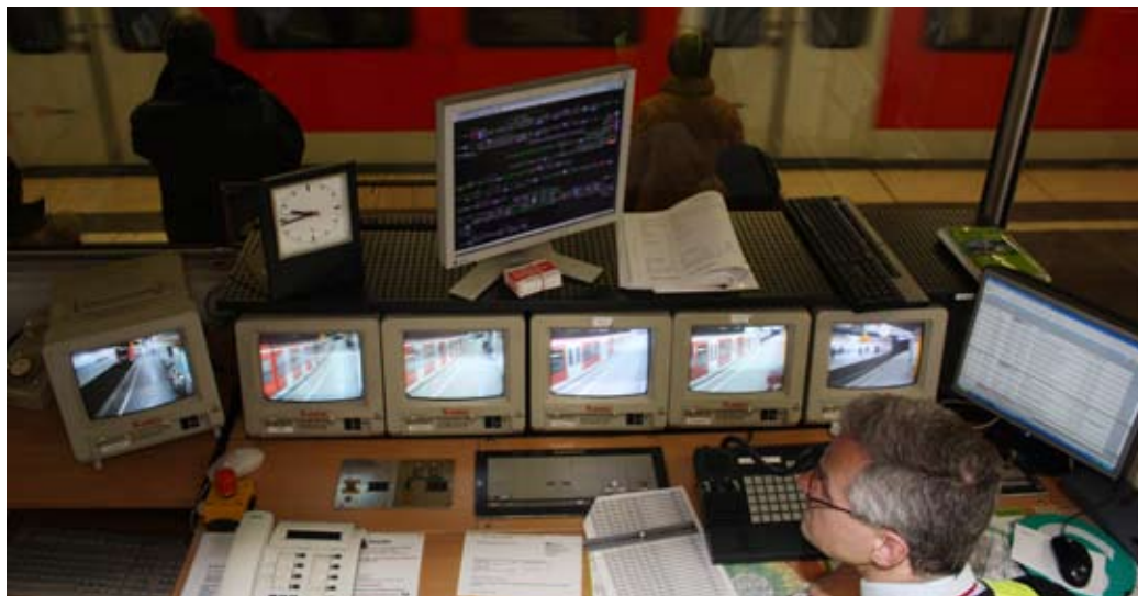
Die Abfertigung fest im Blick: Wolfgang Conrad überwacht die Einfahrt der S-Bahn am Bahnsteig am Marienplatz. Über den Monitoren steht der Streckenspiegel. Vor ihm befindet sich das Mikrophon zur Fahrgastinformation.
