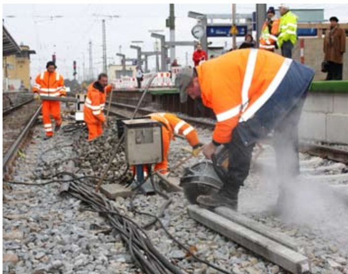
Baustelle Bahnhof Pasing: Die Facharbeiter bereiten den nächsten Bauabschnitt, die Kabelverlegungen für die Bahnsteigdächer, vor.
