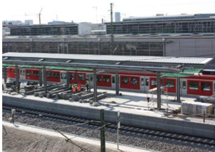
Hirschgarten: Das Bahnsteigdach an der Haltestelle ist bereits montiert. Es folgen die Beschallungs- und Beleuchtungseinrichtungen sowie das Infosystem.
