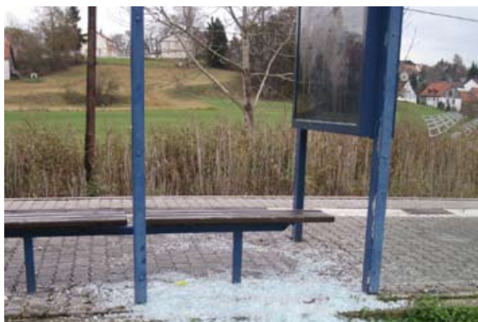
Vandalismus: Unbekannte zerstörten ein Wetterschutzhaus. Der Bahnhofspate meldete die Sachbeschädigung der 3-S-Zentrale und der Schaden wurde behoben.
