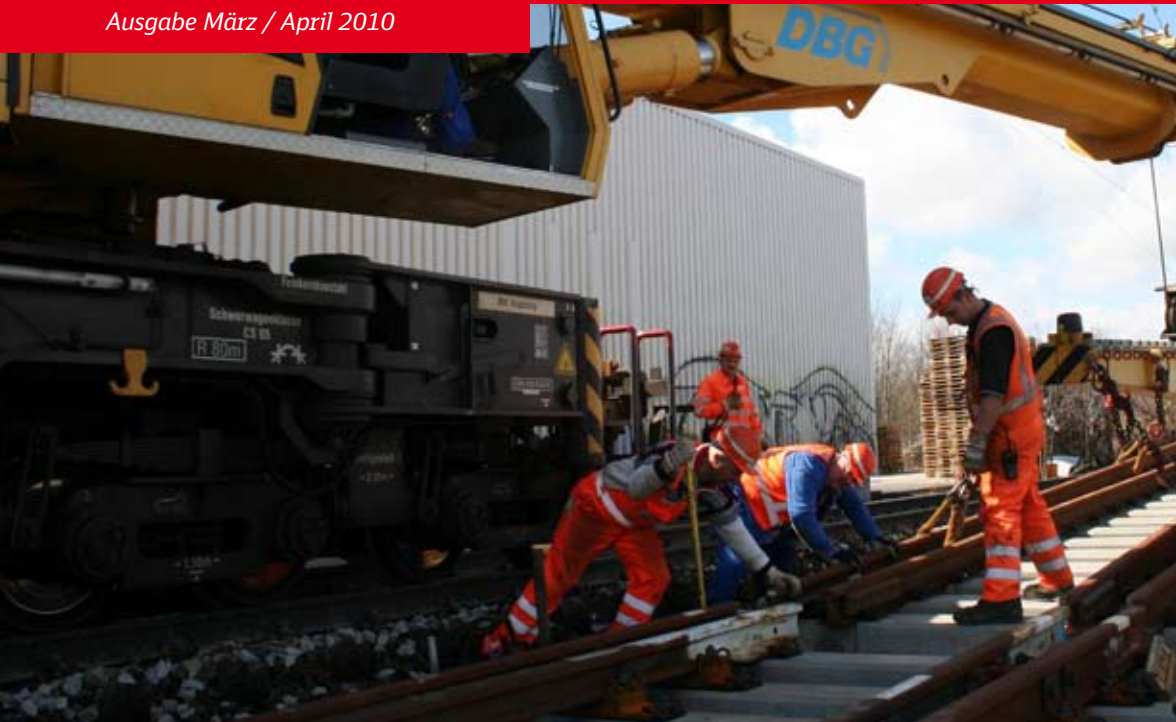
Bautätigkeit: Die Deutsche Bahn macht das Schienennetz fit für die Zukunft. Bei der S-Bahn München stehen in diesem Jahr zwei Großbaustellen im Vordergrund – zwischen Solln und Wolfratshausen sowie der Bahnhof München-Pasing.
